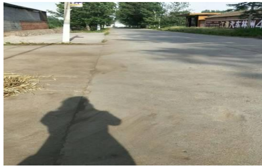
项目区南侧现状
