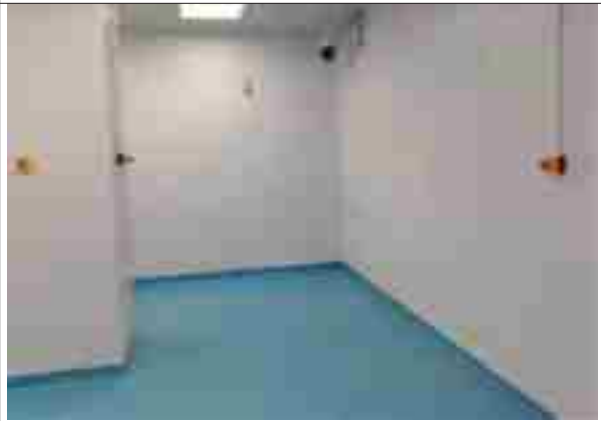
机房东侧后装治疗机房
