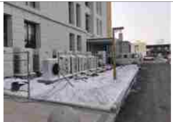
机房上方一层楼外空调外机区和院内道路
