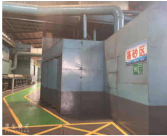
铸二车间现状
