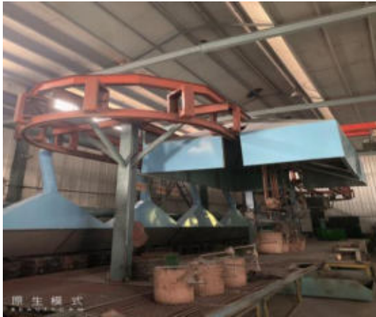
铸二车间现状
