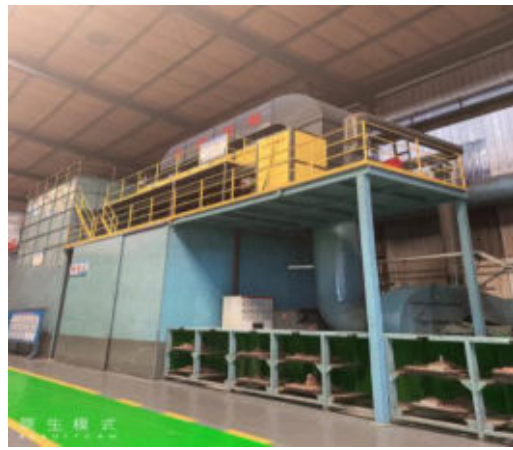
铸二车间现状
