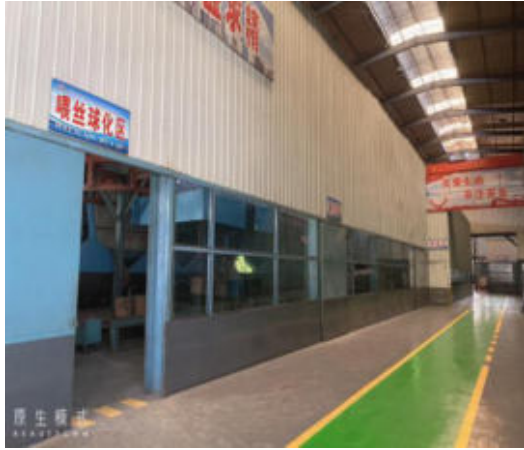
铸二车间现状
